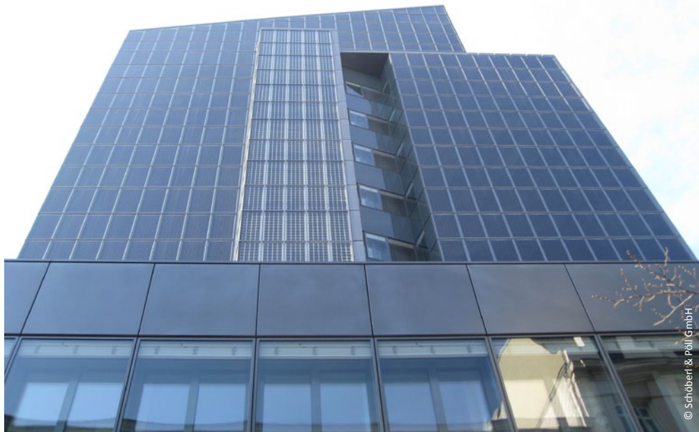
Фасад с солнечными коллекторами
