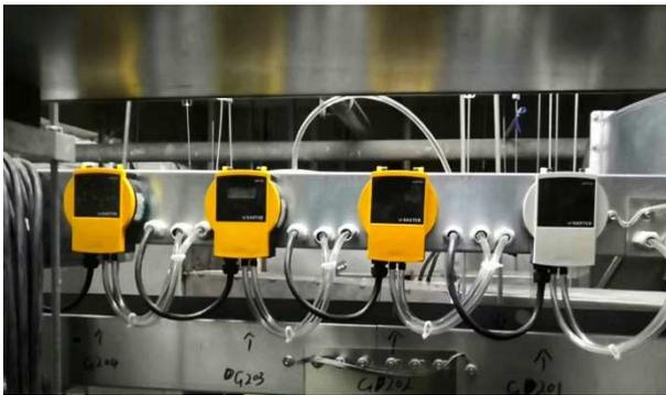
Фото: датчик перепада давления SAUTER (EGP 100) для контроля и мониторинга давления в помещении, установленный на заводе по производству вакцин Sinopharm
